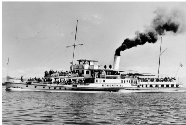
Abbildung 9: Bauzustand nach dem zweiten Umbau 1934/35. (Sammlung Fritz)
